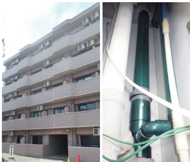
配水管修繕工事
