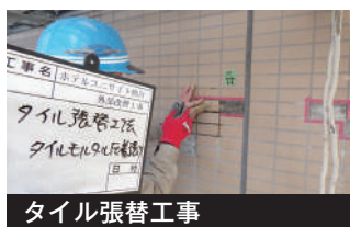
タイル浮補修工事
