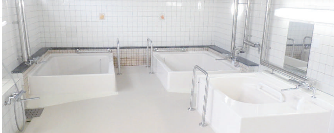
浴室改修工事
