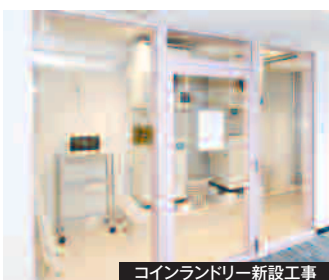
コインランドリー新設工事
