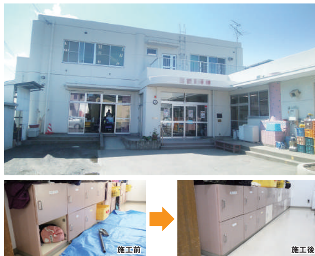
施設内修繕工事
