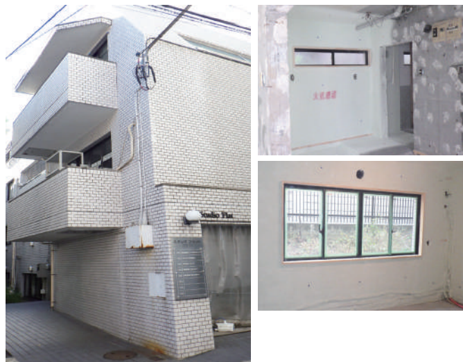
止水・断熱改修工事
