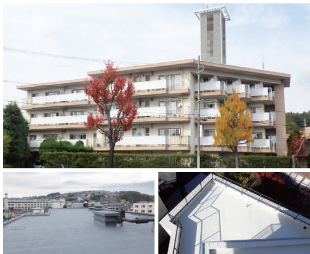
屋上防水改修工事
