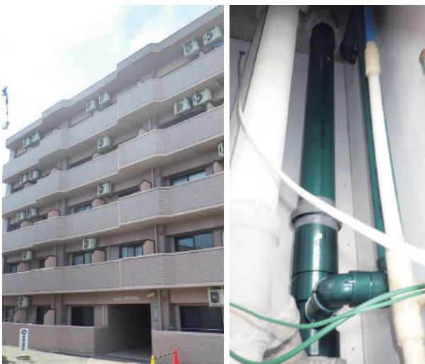
配水管修繕工事
