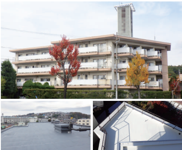
屋上防水改修工事
