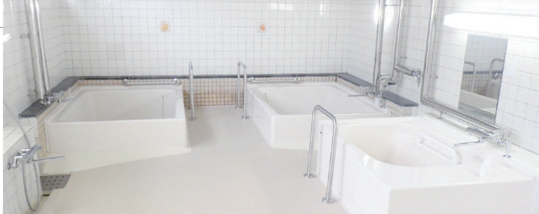
浴室改修工事
