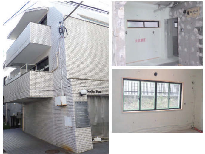
止水・断熱改修工事
