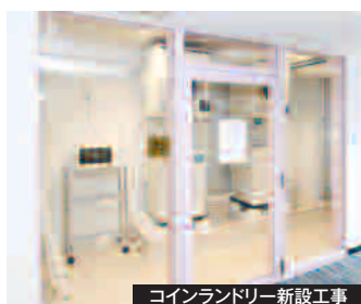
コインランドリー新設工事
