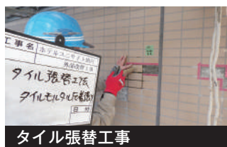
タイル浮補修工事
