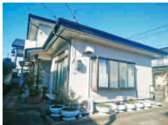
【外部塗装改修工事】
