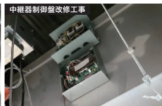
中継器制御盤改修工事
