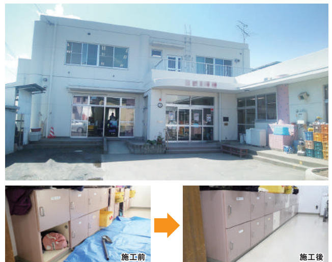
施設内修繕工事
