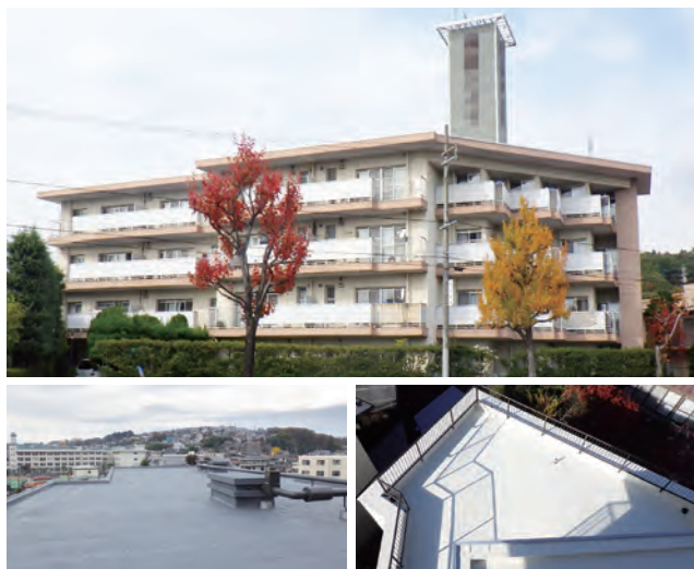
屋上防水改修工事
