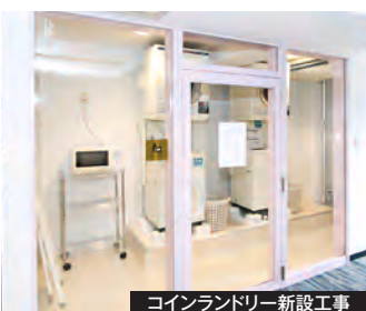
コインランドリー新設工事
