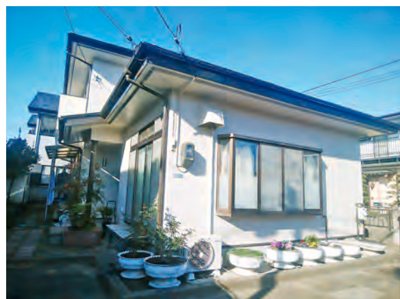
【外部塗装改修工事】
