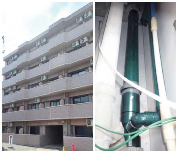
配水管修繕工事
