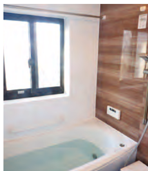
【浴室・洗面所 改修工事】
