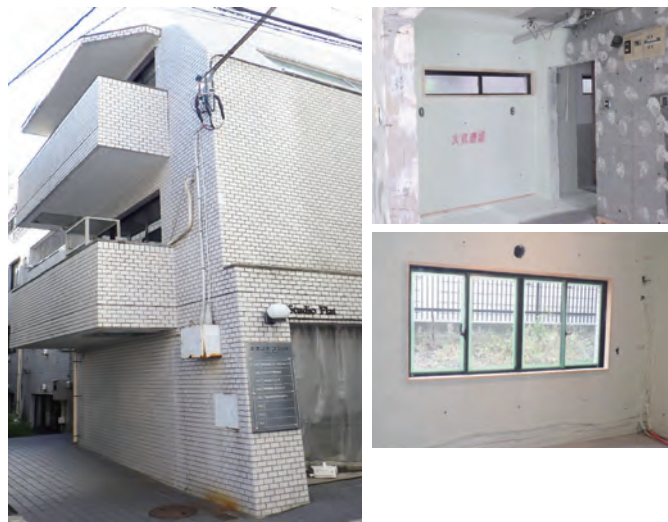
止水・断熱改修工事
