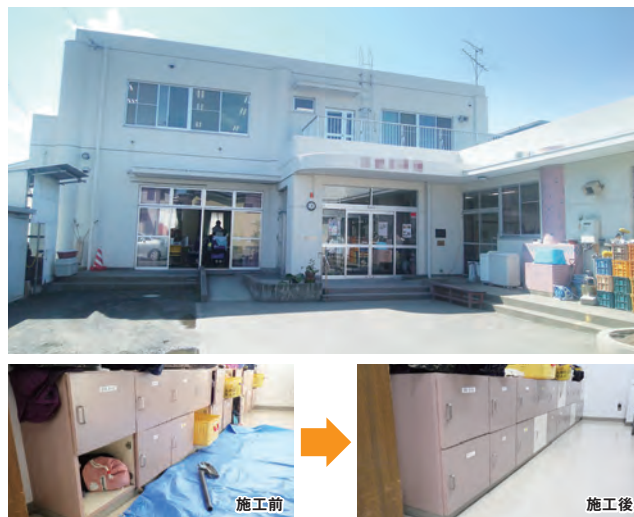
施設内修繕工事
