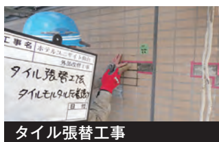
タイル浮補修工事
